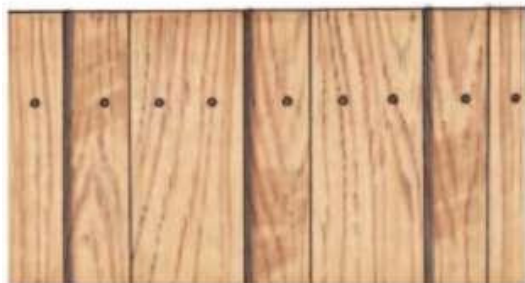
Figur 48 En-på-to beklædning af savskårne eller høvlede brædder med ens bredde, opsat med mindst 25 mm overlæg. Søm eller skruer placeres, så de kun går gennem ét bræt pr. fastgørelse.
