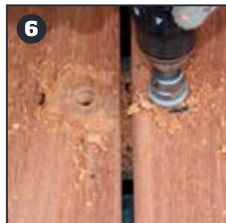
Forboring af huller til propper
